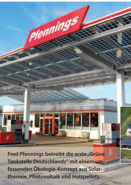
Lichtdurchlässige Photovoltaik-Dächer decken weitestgehend autarken Strombedarf der Tankstelle ab.
